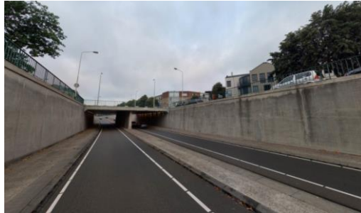
Foto 6-1 Tunnelbak ZRW ter hoogte van de kruising met de Ginnekenweg
